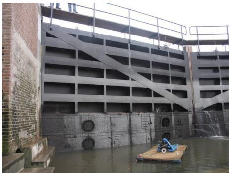
Figuur 20 Sluisdeur, hersteld en verzaamd i.v.m. hogere veiligheidseisen, waarbij oorspronkelijke delen zijn gehandhaafd
