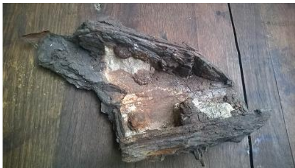
Figuur 1 origineel - geheel gecorrodeerd, als voorbeeld gediend
