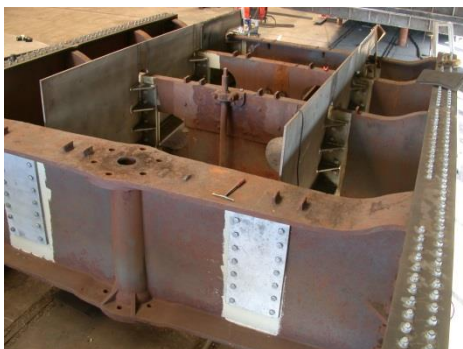
Figuur 21 Brug versterkt i.v.m. zwaarder verkeer, waarbij oorspronkelijke delen zijn gehandhaafd
