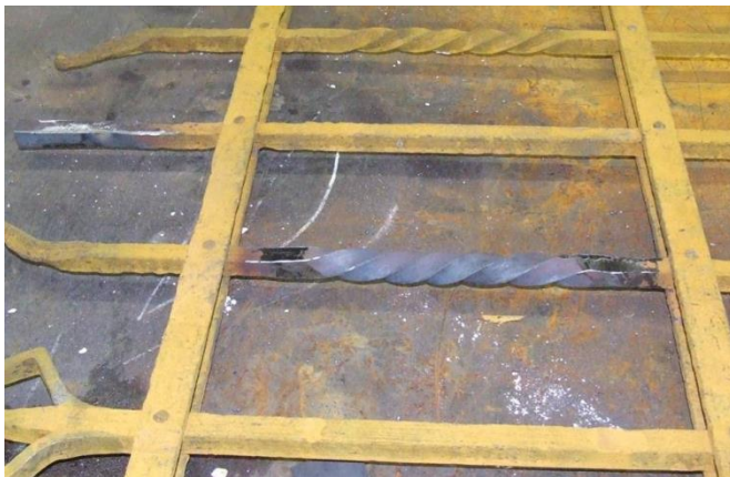
Figuur 15 ingelast stuk getordeerde spijl
